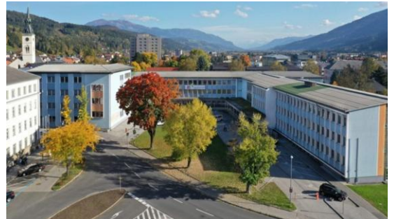
Die MS Spittal vor den Sanierungsarbeiten
